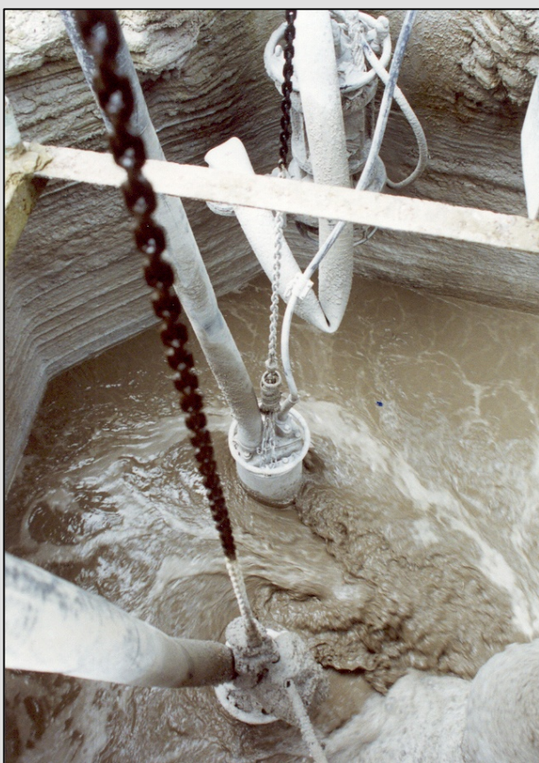
Насосы ET10 и DP10 Бетонный завод
